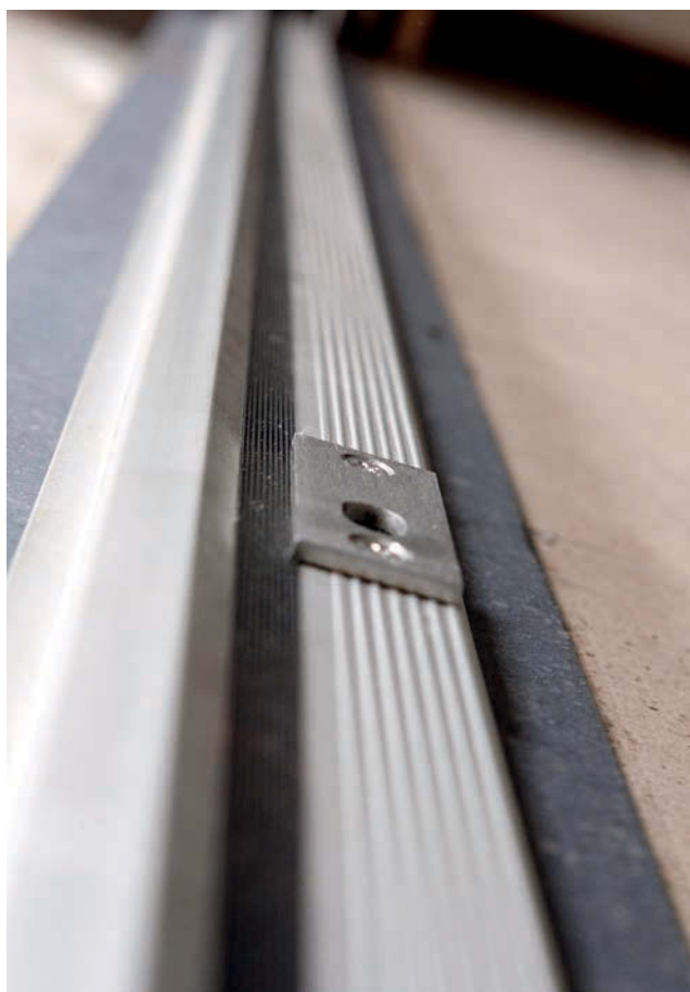
Detail thermisch onderbroken onderprofiel
